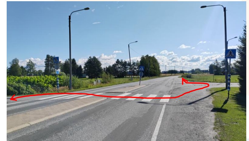
Kuva 7. Maalahdentie–Viaksentie. Maalahdentietä lännestä itään pyöräilevä joutuu jättämään pyörätien ylitettyään suojatien, joka yhdistyy toisen tien jalkakäytävään.
