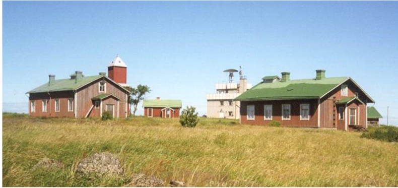
Den moderna lotsstationsbyggnaden avviker markant från den övriga bebyggelsen på Fäliskär. Från vänster: Boningshus I, Båken, bastun, Lotsstationen och Boningshus II. (Foto: AH)
