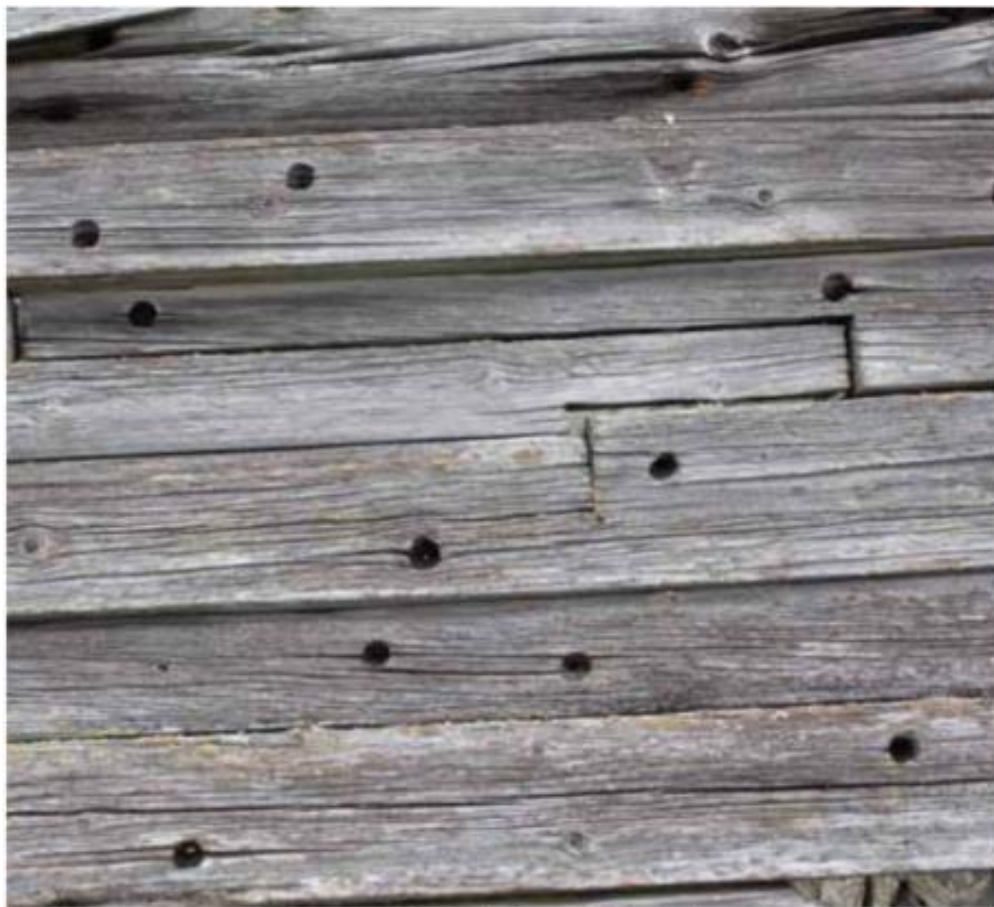
Boden är byggd av vrakdelar, antagligen ett skeppsdäck, att dömma av spikhålen. Vajan jykevät laudat ovat luultavasti, naulanrei'istä päätellen, peräisin laivan kannesta.
