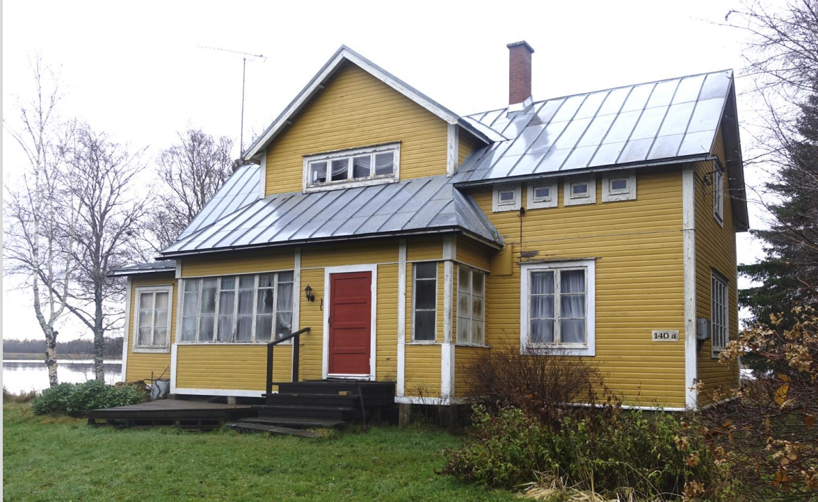
Lomarakennuksen läntinen julkisivu.
