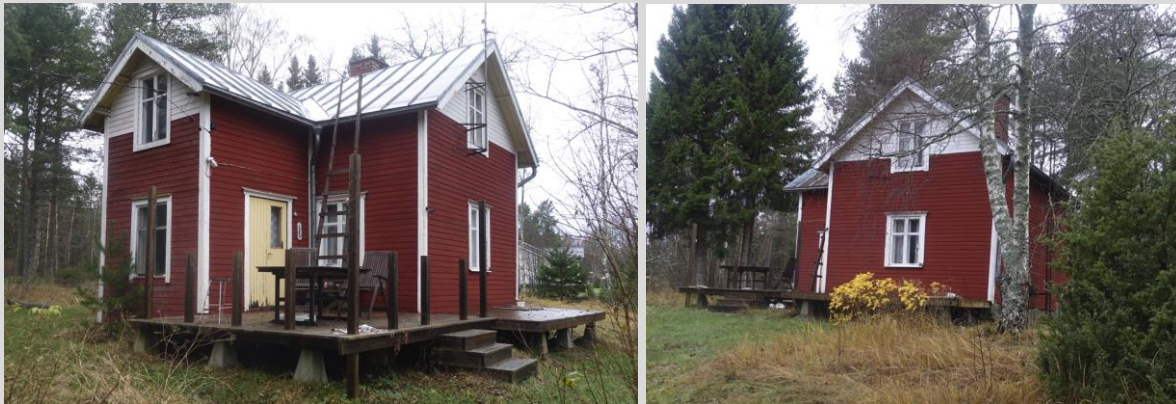
Pihapiiriä ja asuinrakennusta kuvattuna.
