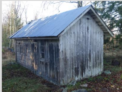
Piharakennus (2) 1900-luvun alusta.
