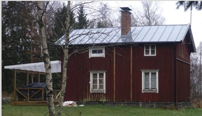
Rakennuksen itäinen julkisivu.
