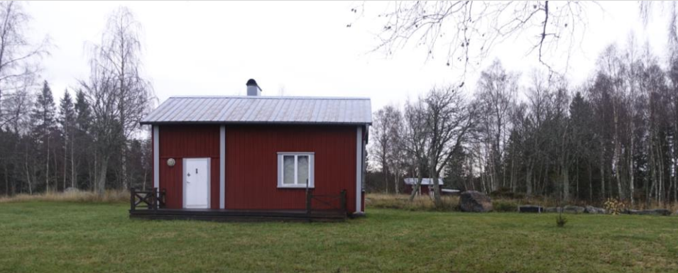
Asuinrakennuksen meren puoleinen läntinen julkisivu.
