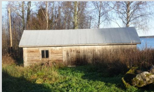
Piharakennus (1) 1900-luvun alusta.
