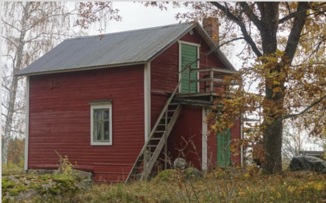
Vapaa-ajanrakennus (1) läntinen julkisivu.
