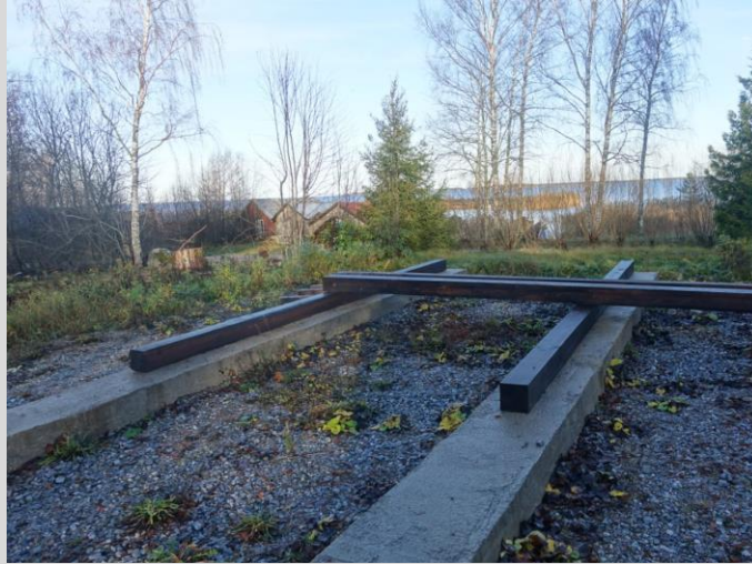
Näkymä rakennuspaikalta meren suuntaan.
