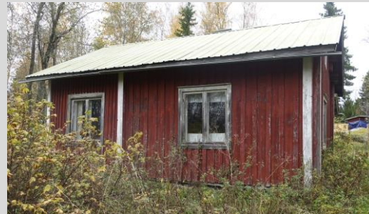
Vapaa-ajanrakennus (3) läntinen julkisivu.
