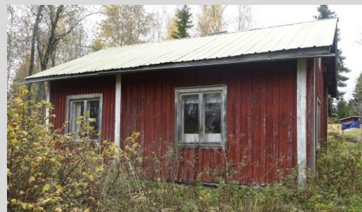
Fritidshus (3), fasad mot väster.
