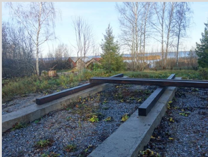
Vy från byggplatsen mot havet.
