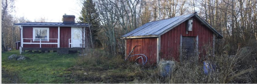
Litet fritidshus från 1950-talet där ändringar gjorts på fasaden.
