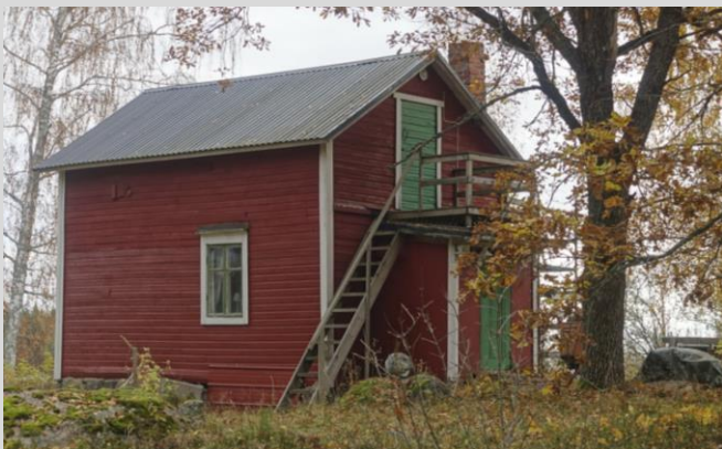
Fritidshus (1), fasad mot väster.
