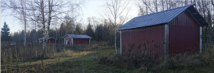
Gårdsbyggnader med varierande fasadmateriäl.
