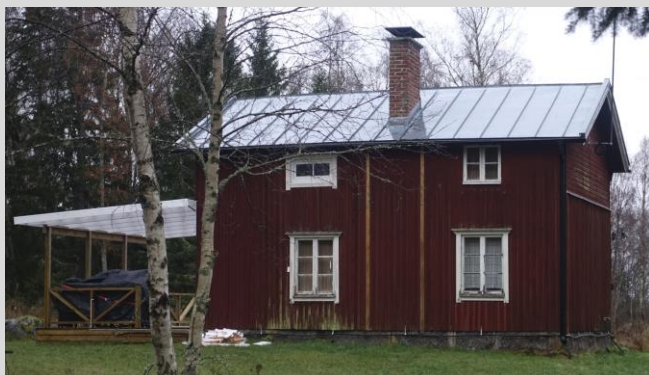
Byggnadens fasad mot öster.
