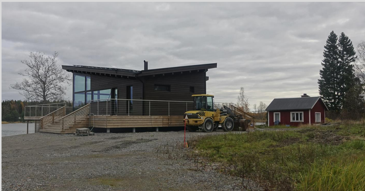
Modernt fritidshus och gårdsbyggnad från 1950-talet.
