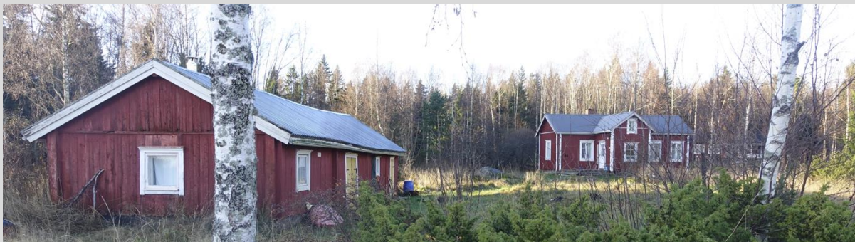
Gårdsområde från början av 1900-talet. Till vänster gårdsbyggnaden och till höger bostadshuset.
