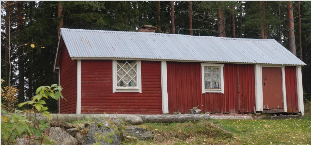
Gårdsbyggnad från slutet av 1800-talet / början av 1900-talet.
