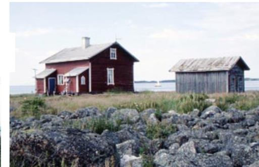
Två fyrvaktarfamiljer bodde vägg i vägg i fyrvaktsbostäder på den avsidat liggande ön Lillsand i södra delen av Kvarken. Närmaste Ledfyr som hörde till fyrrpersonalens ansvarsområde skyttade fram mellan tjänstebyggnaderna
